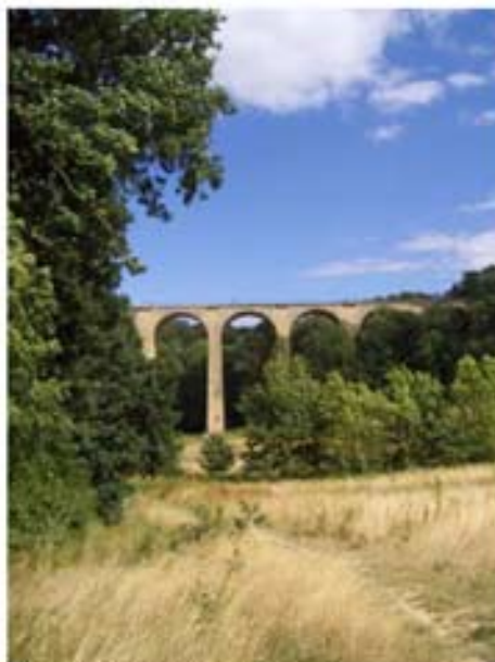
Viaduc des Fauvettes
